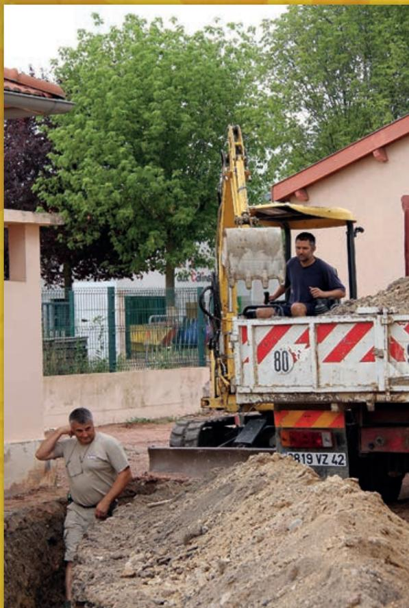
L'assainissement de cet espace a été revu, avec le drainage des eaux pluviales ayant nécessité de creuser une tranchée pour installer les tuyaux.
