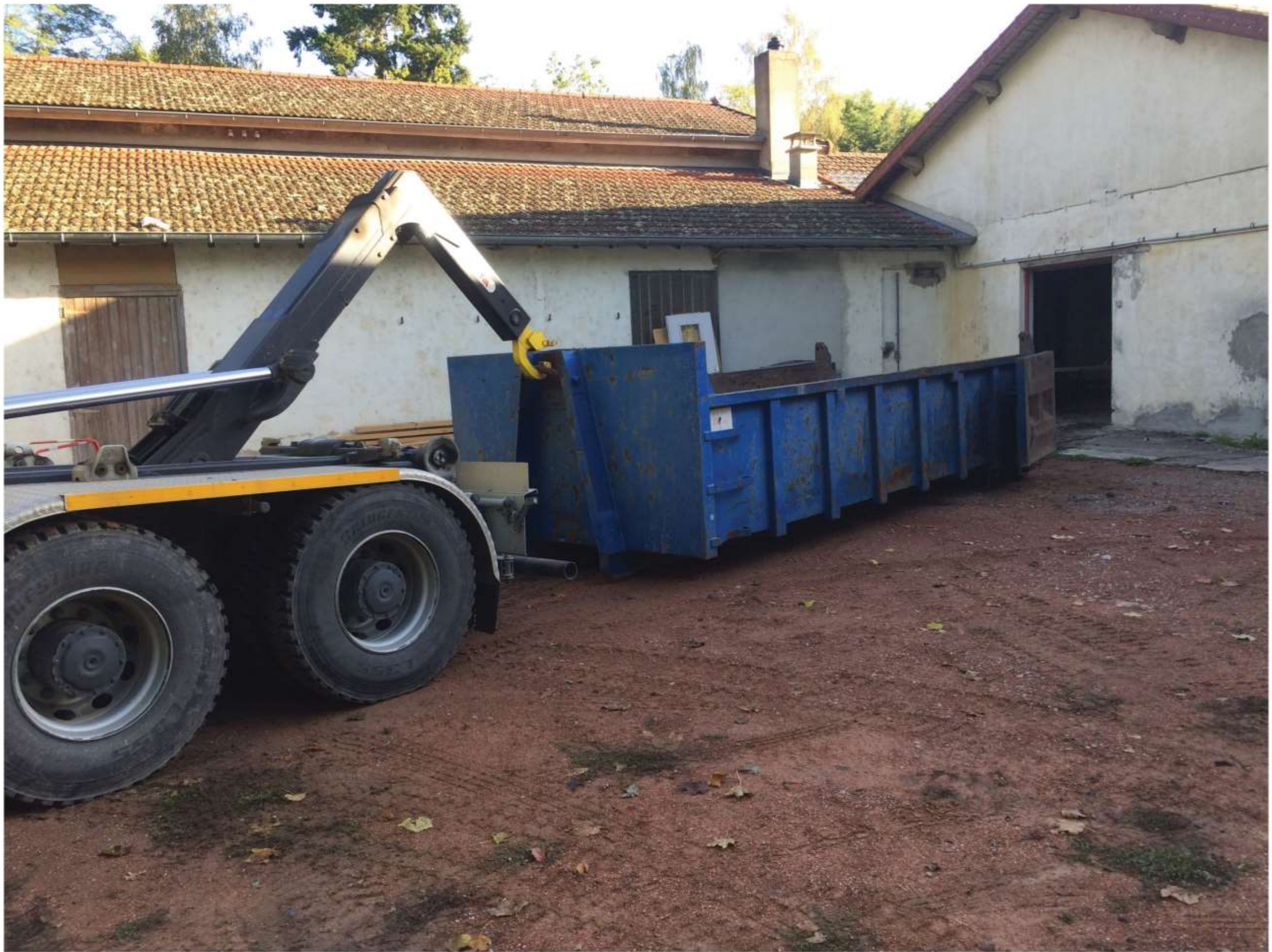
Opération «Evacuation des gravats»
